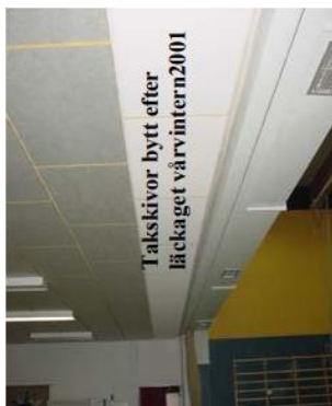
Figur 2. Byte av takskivor, bilaga 2 (5) .
