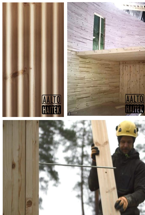
Bild 12. Strukturen på Wave Layered Timber, uppbyggnad av en rund byggnadsstruktur samt montering som sker på ett mycket enkelt sätt.
