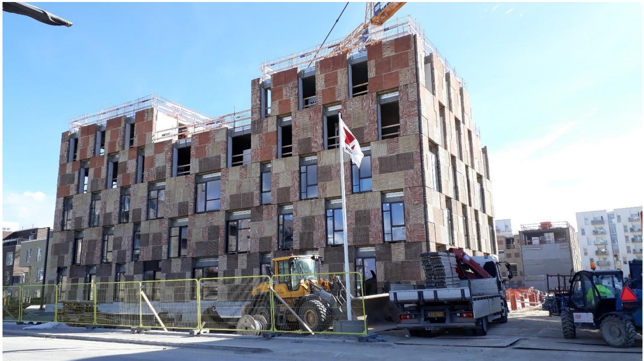
Kuva 2. Resource Rows -rakennuksessa on käytetty vanhojen purettavien rakennusten tiiliseiniä, jotka on leikattu moduuleiksi, ja niistä on koottu uusia seiniä. Myös vanhasta Kööpenhaminan metrorakennuksesta purettua puumateriaalia on uudelleenkäytetty. (Kuva Virpi Palomäki ja Paula Pihlaja, CE Wood -projekti)
