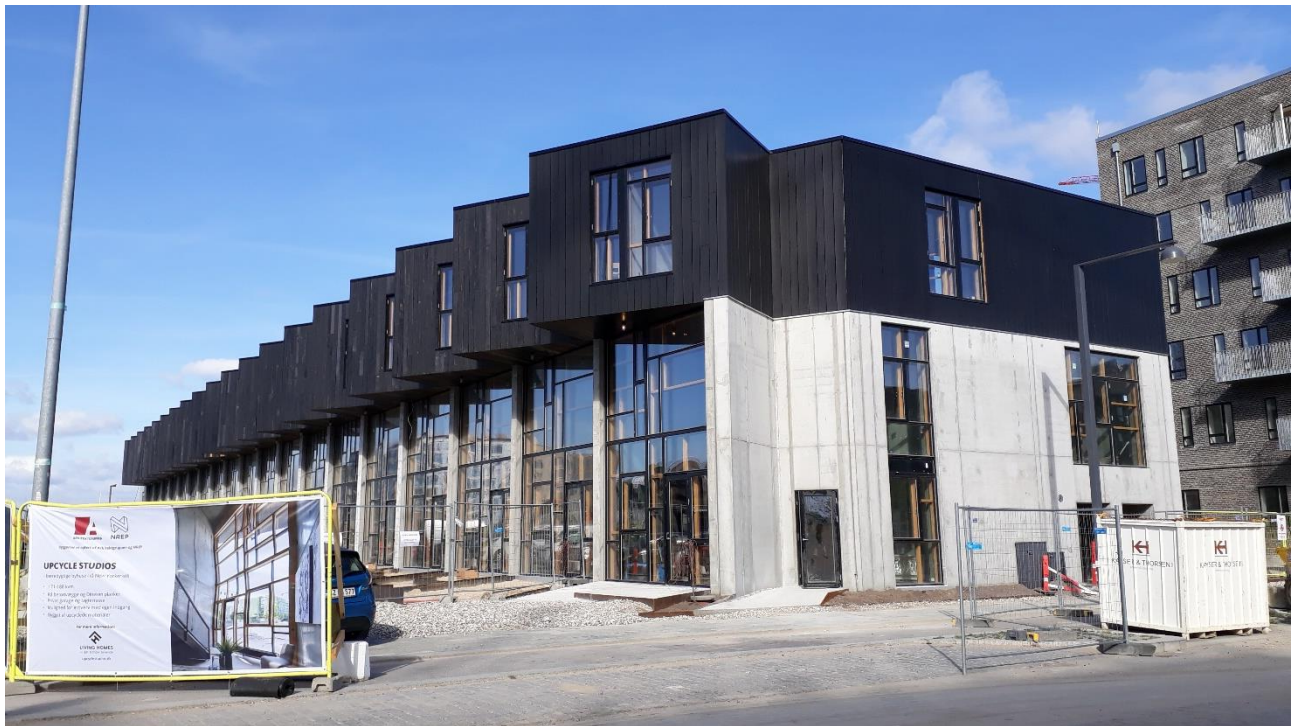
Kuva 1. Upcycle Studios Ørestadissa Kööpenhaminan eteläisellä alueella, 75 % ikkunoista on peräisin käytöstä poistetuista rakennuksista. (Kuva Virpi Palomäki, CE Wood -projekti)
