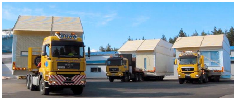
Kuva. 20. Moduulit siirretään perustuksineen. Kuva Teijo-Talot Oy
