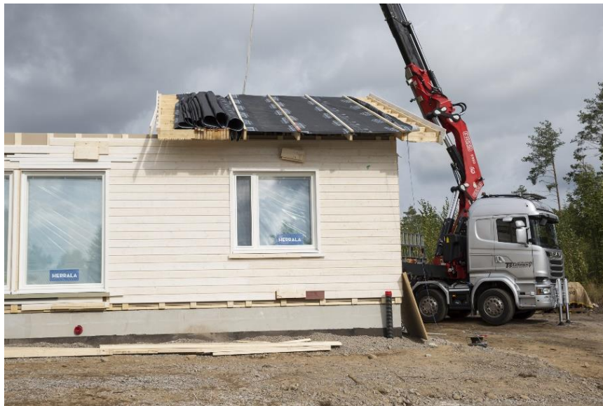
Figure 17. Installing a VETOKATTO® roof. Photo: www.rakennuslehti.fi
