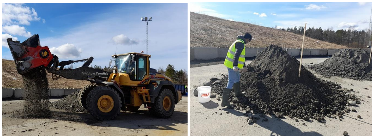
Figur 5.1. Inblandning av bindemedel i sulfidjord med Allu Transformer-skopa modell DS 4-23 (till vänster) och provtagning av blandad jord för geotekniska analyser (till höger). Foto: Eva Högfors-Rönnholm.
