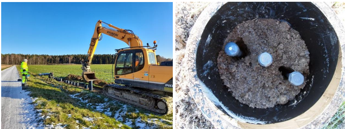
Figur 4.1. Installation av mesokosmrören (till vänster). Ett färdigt mesokosmrör med två injektionsrör (med skruvkork) och ett grundvattenrör (med vitmarkerad rund kork) (till höger). Foto: Eva Högfors-Rönnholm och Sten Engblom.
